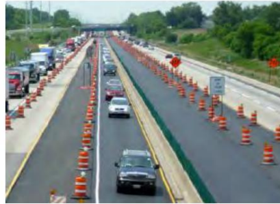
Delimitar los carriles de circulación durante los trabajos de repavimentación.
