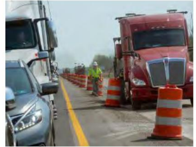
Amortiguador lateral de la carretera
